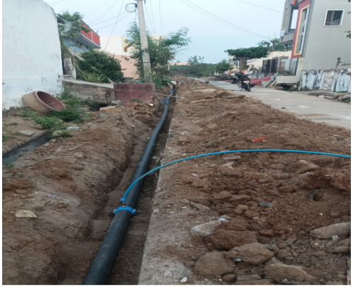
చేయించి, నూతన పైప్లైన్ పనులకు శ్రీకారం చుట్టారు. అవార్కిలను శ్రమించిన ప్రజాప్రతినిధులు పైప్లైన్ పనులు
